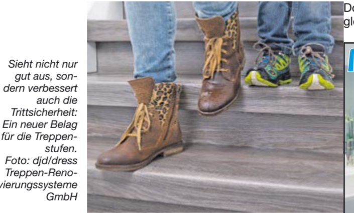
Sieht nicht nur gut aus, sondern verbessert auch die Trittsicherheit: Ein neuer Belag für die Treppentritte. Foto: djd/dress Treppen-Renovierungssysteme GmbH
